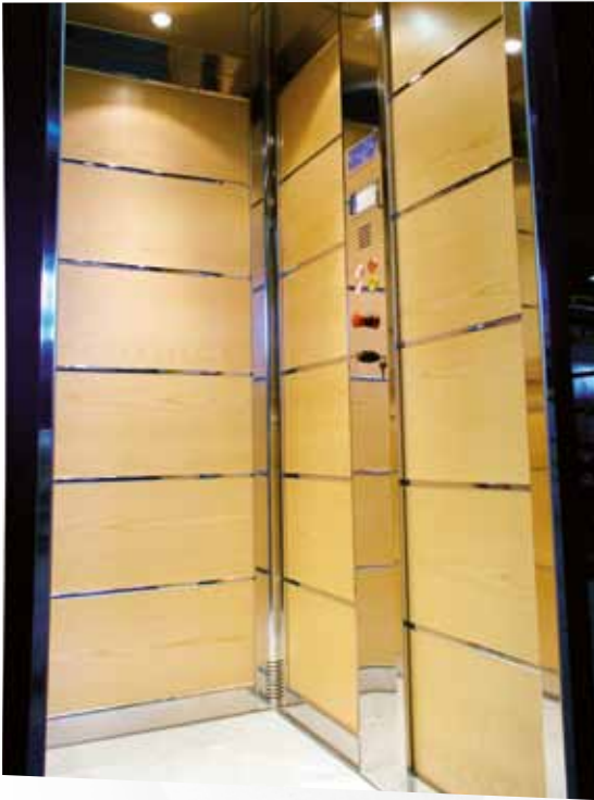
Cabina con pareti rivestite in laminato plastico e finiture in inox BA
